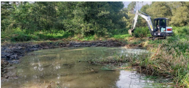
Obnova tůňe těžkou technikou, část porostu vegetace zůstane na svém místě.
